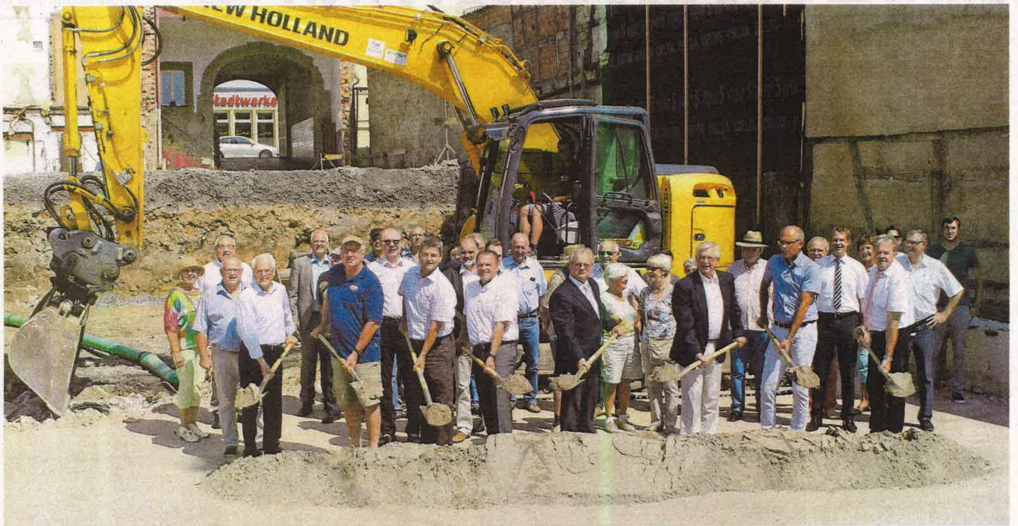
Baugenossenschaft, Verwaltung, Stadträte, Alt-Stadträte und Mietinteressenten haben gemeinsam den ersten Spatenstich gefeiert.
